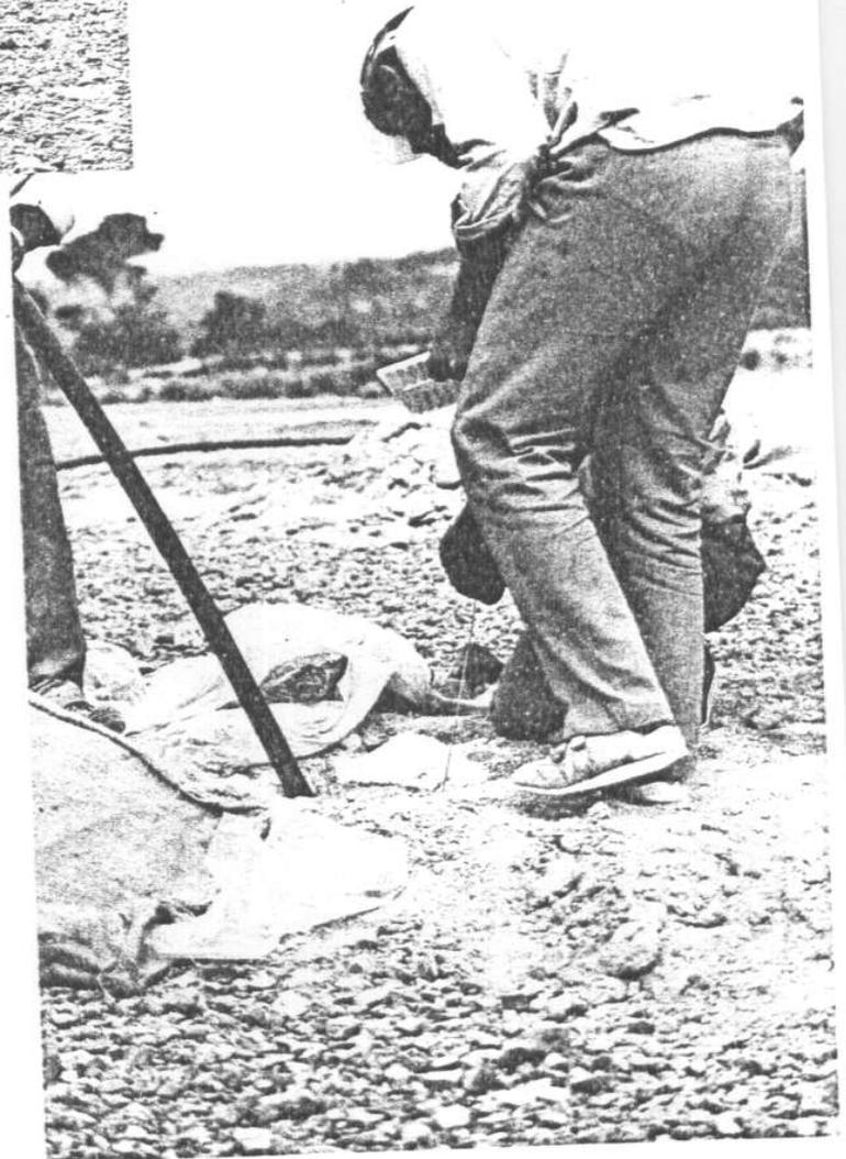
Tubo de PVC empleado como atacador y para el control de profundidades.
