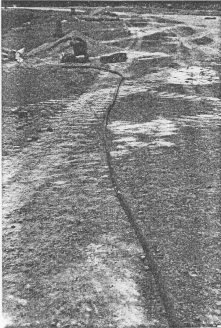
Tubería de PVC con señales de medida para el control de alturas.
